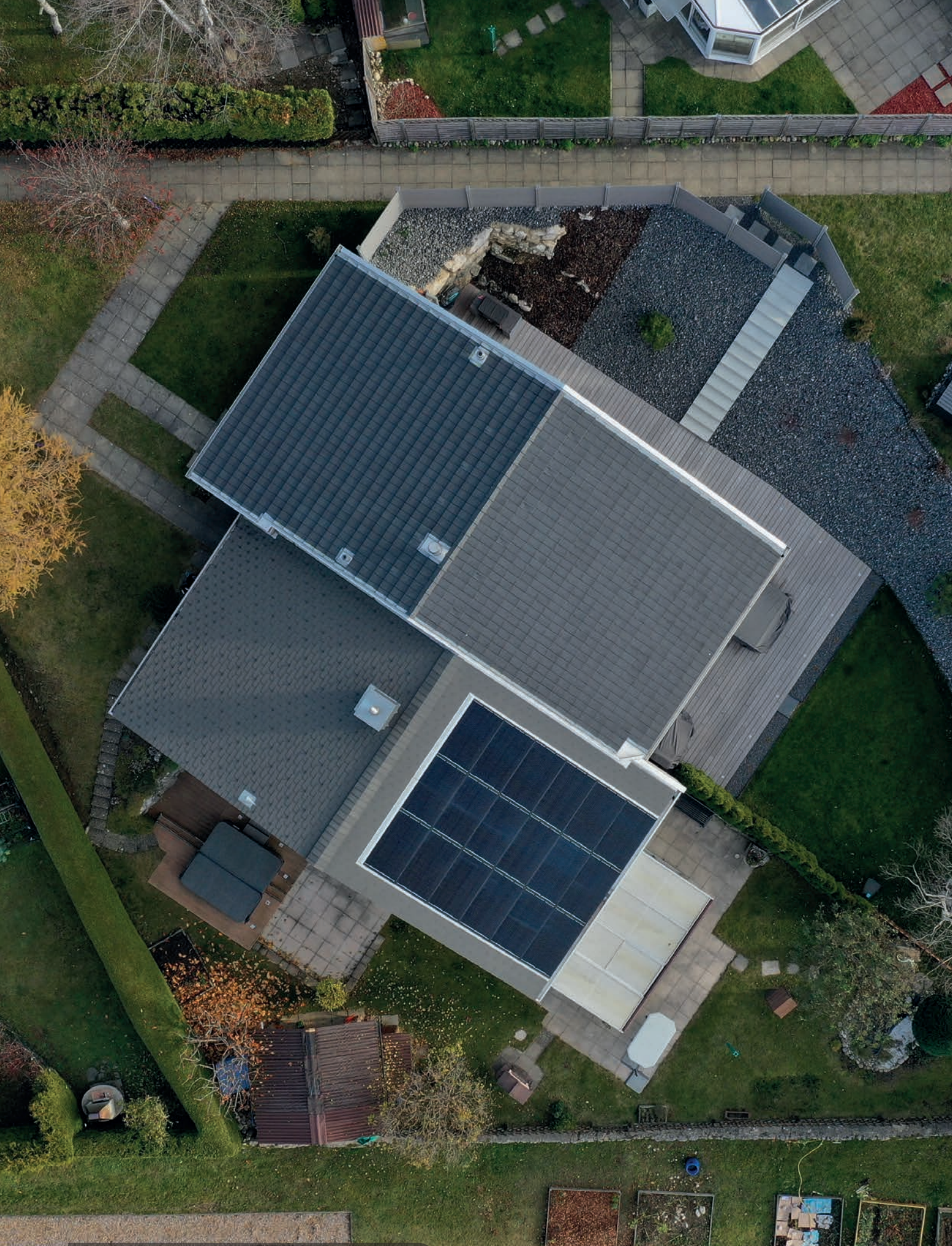
Installation photovoltaïque, La Chaux-de-Fonds
