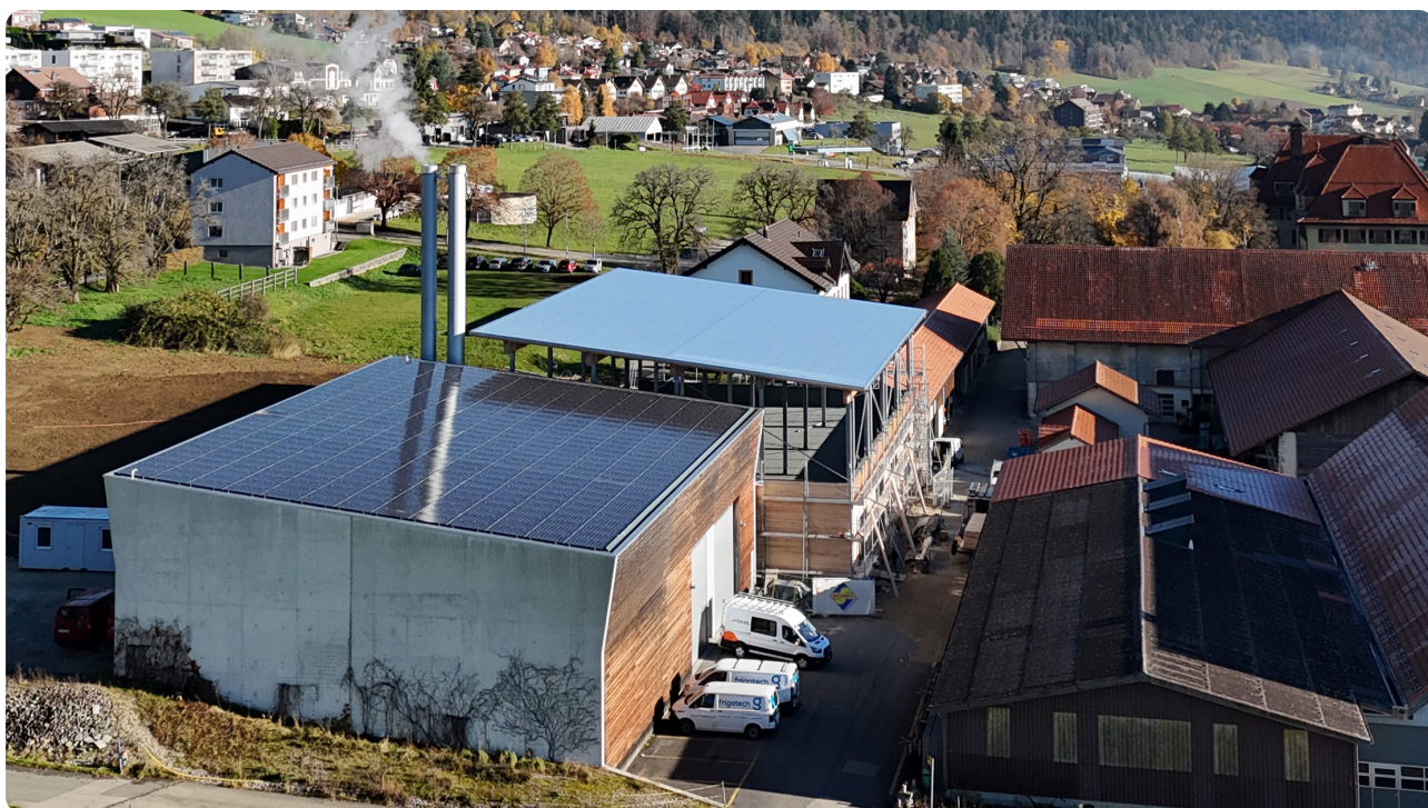
Centrale de production du chauffage à distance Vivaldis
