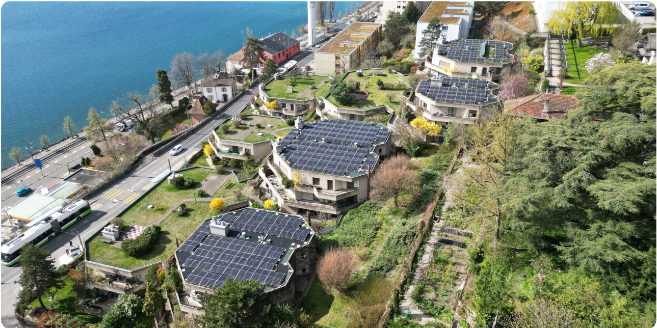
Installation photovoltaïque et RCP (Regroupement de consommation propre) à Neuchâtel
