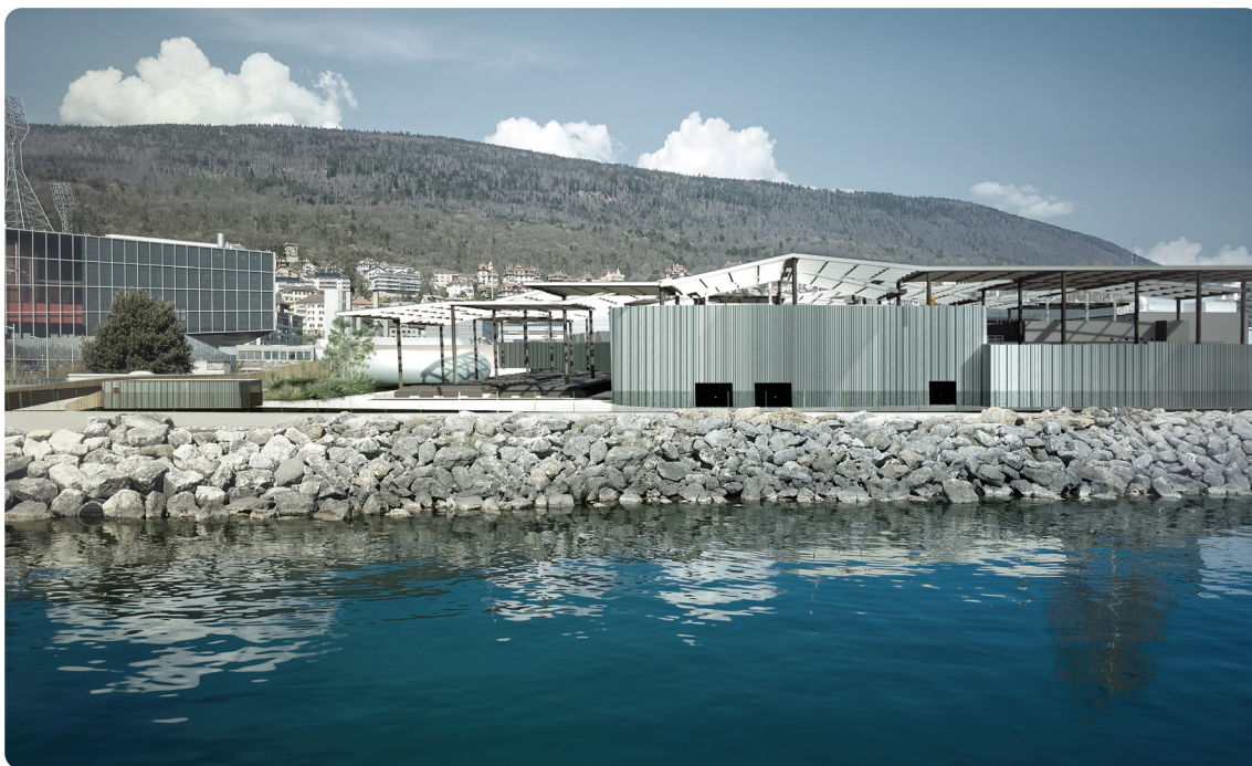
La valorisation des rejets de chaleur de la STEP de Neuchâtel contribuera à augmenter la part d'énergie renouvelable dans le réseau. STEP Neuchâtel
