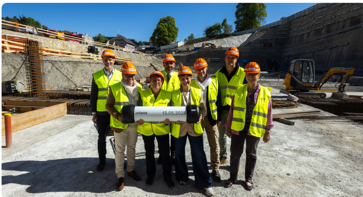
Pose de la première pierre du site principal : le bâtiment, exemplaire en termes d'efficacité énergétique, contribuera à notre engagement pour la durabilité.
